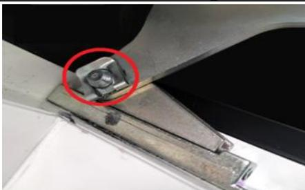
**7 Den Stützarm vom Flügel durch Lösen der Schrauben von der Halterung demontieren.**
