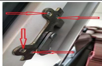
**8 Öffnungen für die Prägung in das PVC – Profil nach der Schablone bohren. Die Stahlverstärkungen dürfen nicht durchbohrt werden.**
